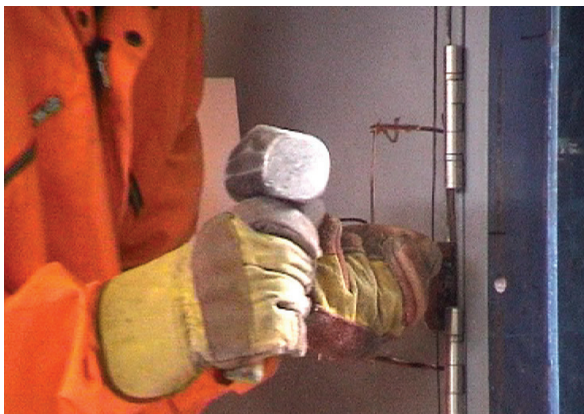
Aanval op de deur met een hamer en beitel om het deuropervlak te verwijderen.
